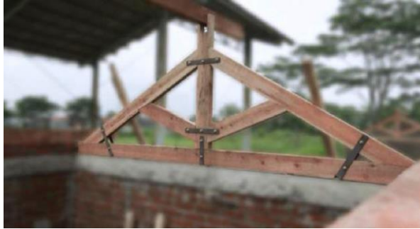
Gambar 3. 15 Pemasangan Plat Baja pada Kuda-Kuda Kayu
