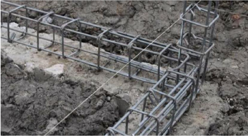
Gambar 3. 22 Hubungan Antara Tulangan Balok Pengikat/Sloof dengan Tulangan Kolom
