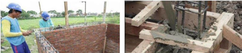
Gambar 3. 30 Perangkaian Tulangan Balok Keliling/Ring di atas Dinding
