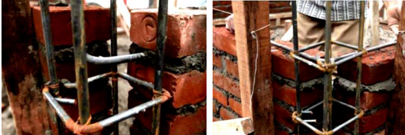
Gambar 3. 24 Pemasangan Angkur Besi Sebagai Pengikat Antara Kolom
